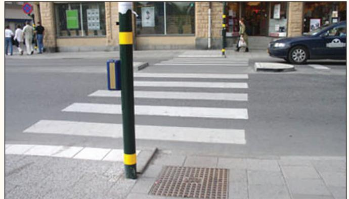
Figura 11 - Stoccolma (Svezia): attraversamento pedonale compatibile con disabilità motorie (scivolo) e visive (gradino e segnaletica tattile sul piano di calpestio). Il palo semaforico è riconoscibile da lontano per l'uso di un forte segnale cromatico (bande gialle). Foto: I. Steffan
