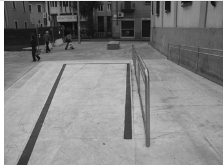
Figura 4. Cinisello: particolare della piazza, vista dall'alto, dopo il primo trattamento del marmo per una più efficace percezione dei gradini.
