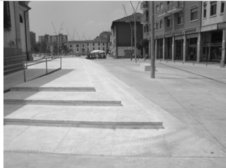
Figura 3. Cinisello: particolare della piazza, vista dal basso; la percezione dei gradini risulta difficile, in mancanza di ombre.
