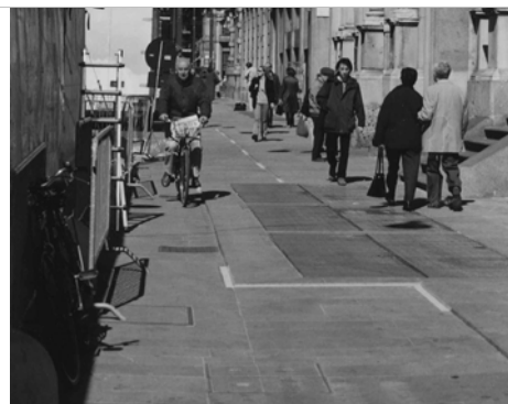
Figura 1. Milano, Via Mercanti: pavimentazione con il nastro provvisorio utilizzato per evidenziare il piccolo risalto del marciapiede.
