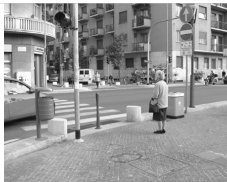
Figura 2. Milano, criticità relative alla mobilità pedonale di utenti deboli: attraversamenti pedonali (es. di attraversamento in quota, senza segnalazione tattile a pavimento)
